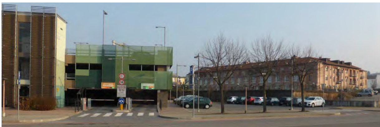
Vista verso edifici residenziali
