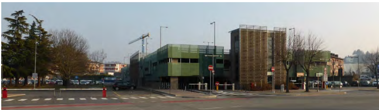
Vista verso parcheggio a raso
